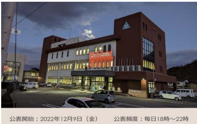
図3 市役所本庁舎ライトアップ
